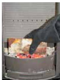
Дверцу печи обычно следует сначала приоткрыть на 2-3 см, затем подождать до выравнивания давления и уже открывать её полностью. Таким образом дым не попадёт в помещение, особенно при слабой тяге.
